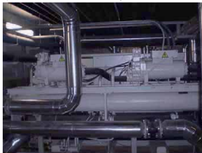
Figura 137. Enfriadora instalada.
