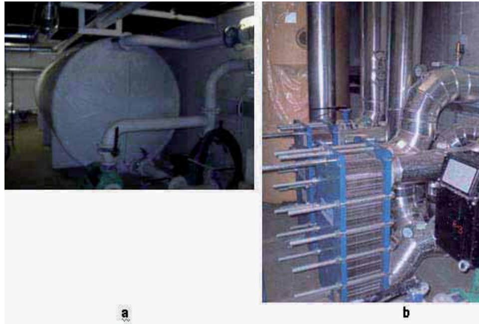
Figura 138. Depósito regulador (a) e intercambiadores de calor (b)
