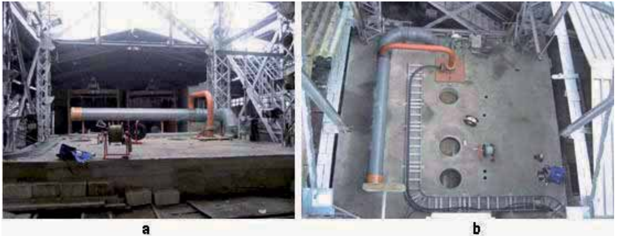
Figura 149. Sellado de hormigón de la caña del pozo Barredo (a) y vista superior del mismo (b) (Álvarez, 2009)
