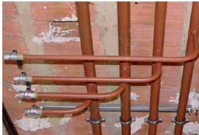
Figura 133. Detalle de la distribución de frío y calor a cuatro tubos.
